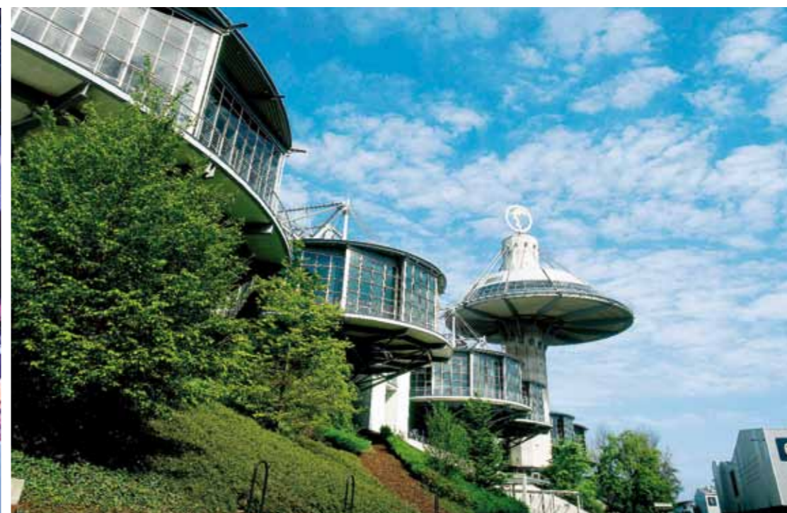
Convention Center | Messegelände Hannover
